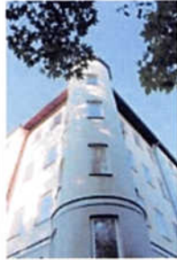
Bei der künftigen Gestaltung des Schlosses will sich der Architekt an früheren, historischen Ansichten orientieren.
